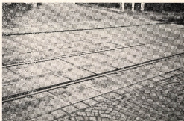
12. ábra. Jó állapotú, előregyártott elemmel kialakított útátjáró
