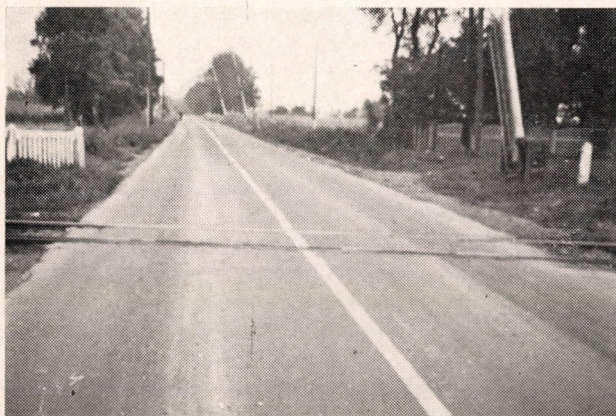
5. ábra. Útmegeősítéssel egyidejűleg korszerűsített keresztezés
