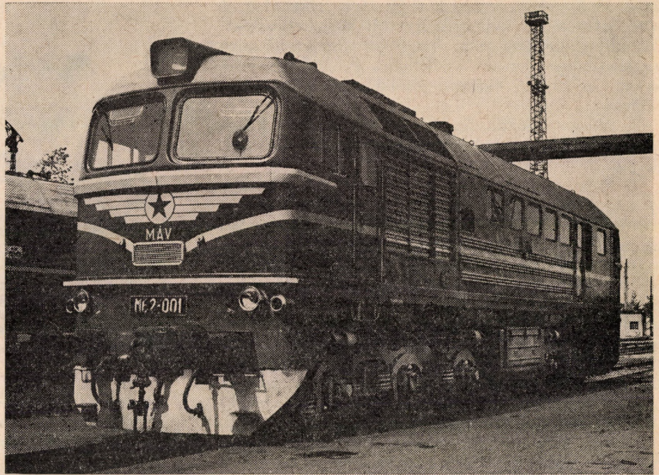
2. ábra. Az M 62 sorozatú, 2000 LE-s dízelvillamos mozdony
