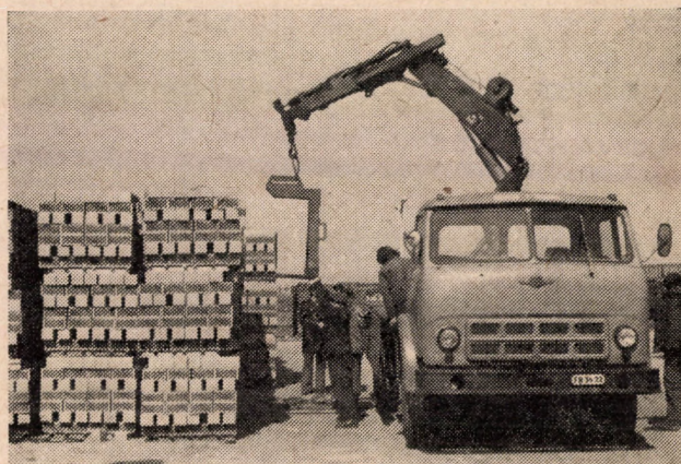
5. ábra. Zsebes egység-akadályozóvilla rakodása villával MAZ 500 A-ra szerelt HIAB 550/2. típusú daruval
