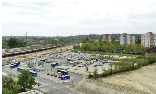
Örmezői oldali P+R parkoló
