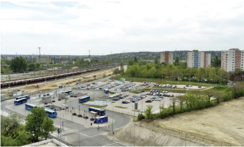
Örmezői oldali P+R parkoló
