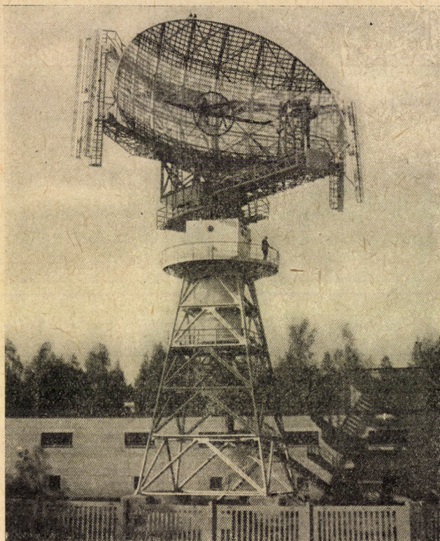
8. ábra. A korszerű, nagy hatótávolságú „Utyosz” radar antennarendszere és épülete
