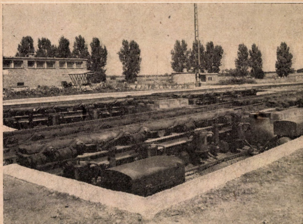
3. ábra. Rendezőpályaudvari vágányfék berendezés
