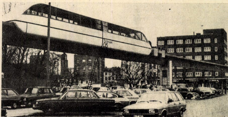
9. ábra. Mágneses vasút kísérleti pályája és járműve a hamburgi kiállítás területén
