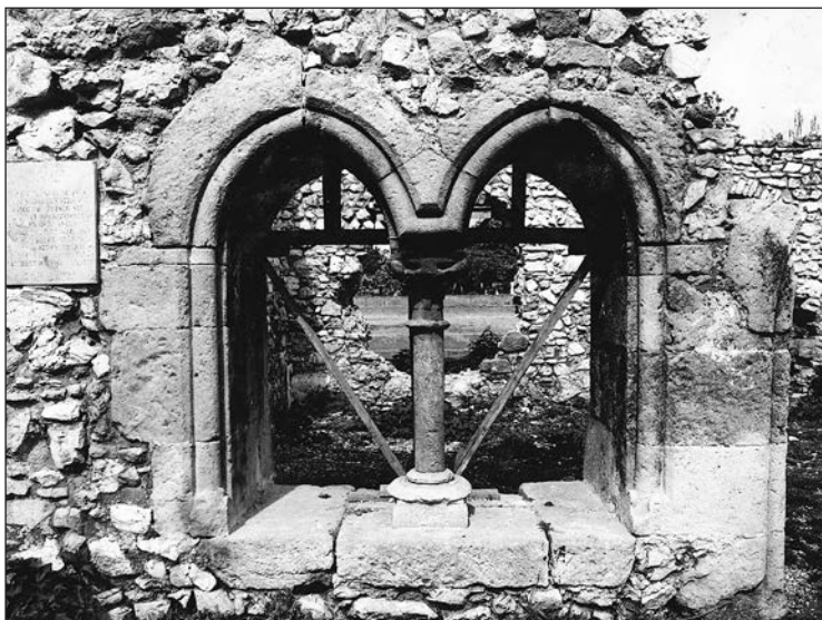
5. kép: A káptalanterem (belső oldala felől ideiglenesen alátámasztott) ikerablakának homlokzati fényképe. 1962–1964 között (MÉM MDK Fotótár 115135N.)
