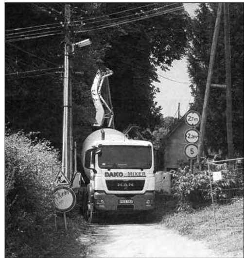
Folynak a betonozási és külső építési munkák
