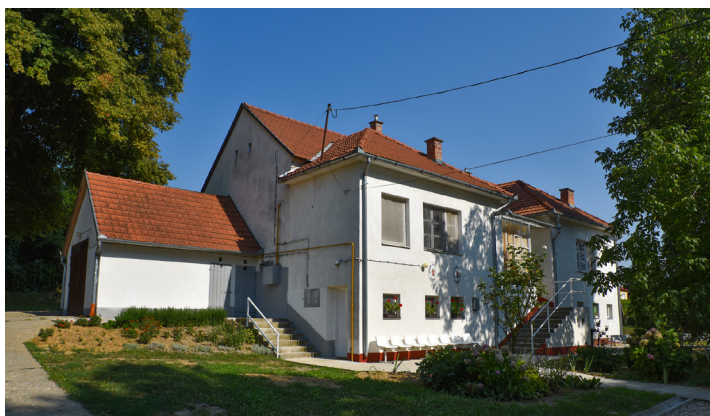
A Városi Szociális Intézmény épülete a 2018-as felújítást megelőzően
