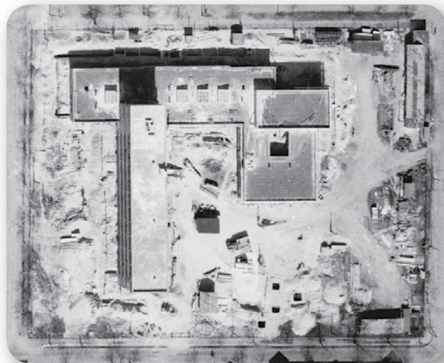
A gimnázium építkezése 1964. 02. 15-én
