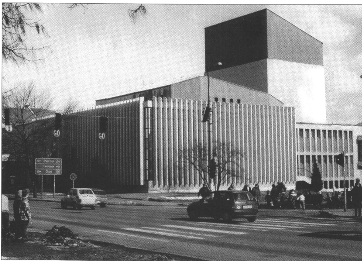
Az egri színház az átépítés előtt...
