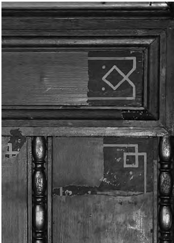
Restaurátorok által feltárt eredeti felület és díszítés a Nagyterem fa falburkolatán, amelyet a felújítás során visszaállítanak
