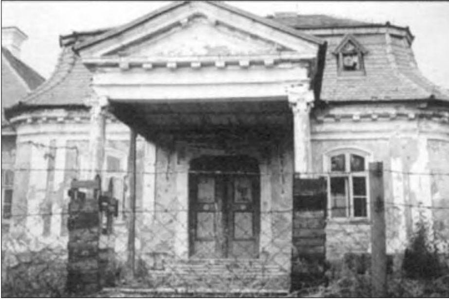
A zselizi kastély főbejárata
