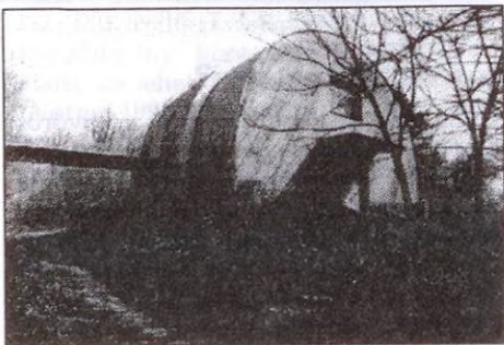
A passzázsműszer épülete a vákuumcsövekkel
