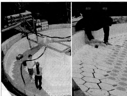
2. ábra. Az öntőforma készítése
