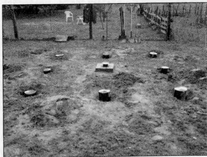
Kész az alapozás – még az észlelőhelyiség nélkül
