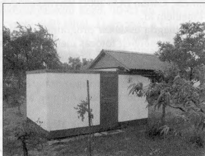
A kész épület nyitott tetővel derült égre vár
