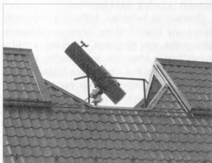
A Kistáltos Csillagvizsgáló eltolható teteje két csövön gurul a fix tető fölé. A távcsőtubus 2"-os okulárhuzattal, keresővel és egy 50/500-as vezetőtávcsővel van ellátva
