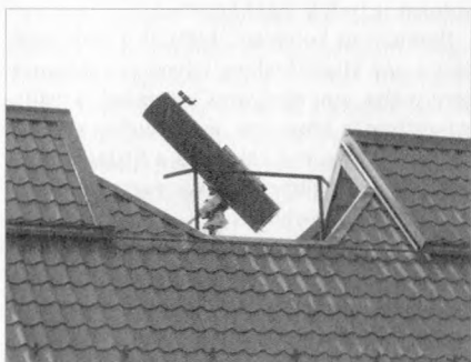
A Kistáltos Csillagvizsgáló eltolható teteje két csövön gurul a fix tető fölé. A távcsőtubus 2"-os okulárikhuzattal, keresővel és egy 50/500-as vezetőtávcsővel van ellátva
