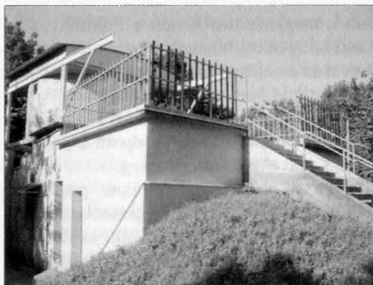
A csillagvizsgáló a felújítás után
