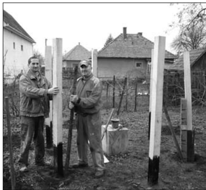
Földbe kerültek a vázszerkezet tartóoszlopai
