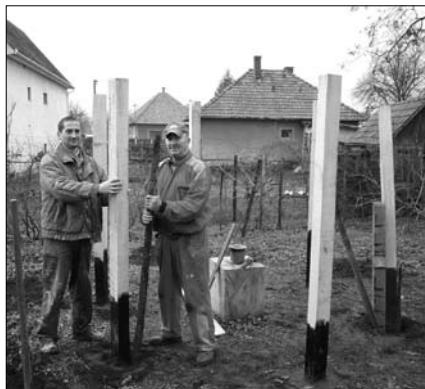
Földbe kerültek a vázszerkezet tartóoszlopai
