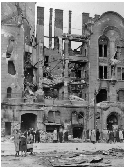
A Móricz Zsigmond körtér 2. számú bérház homlokzatát ez a szép napóra díszítette (fent). A harcok következtében megsérült épületrészt néhány évvel később a napórával együtt elbontották, helyére modern társasházat építettek (FSZEK, Fortepan)
