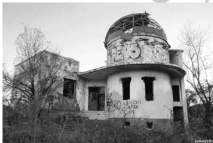
A székelyudvarhelyi csillagvizsgáló leromlott állapotú épülete (fotó: Pál Árpád)
