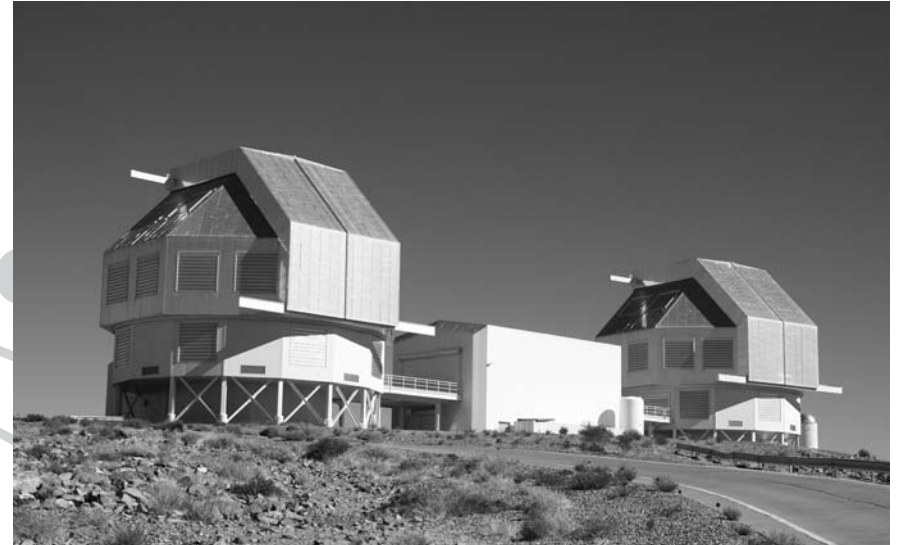
A Las Campanas Observatórium koronaékszere: a két, egyenként 6,5 m-es Magellan távcső épülete
