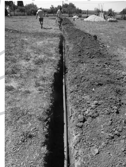
Az épülő kupola tápellátását biztosító vezeték árka július közepén (Mizser Attila felvétele)
