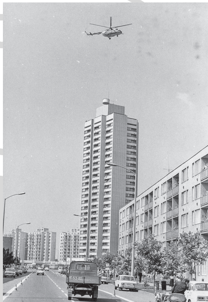
Nagy pillanat a szolnoki toronyház életében: beemelik a csillagvizsgáló kupuláját (1979)
