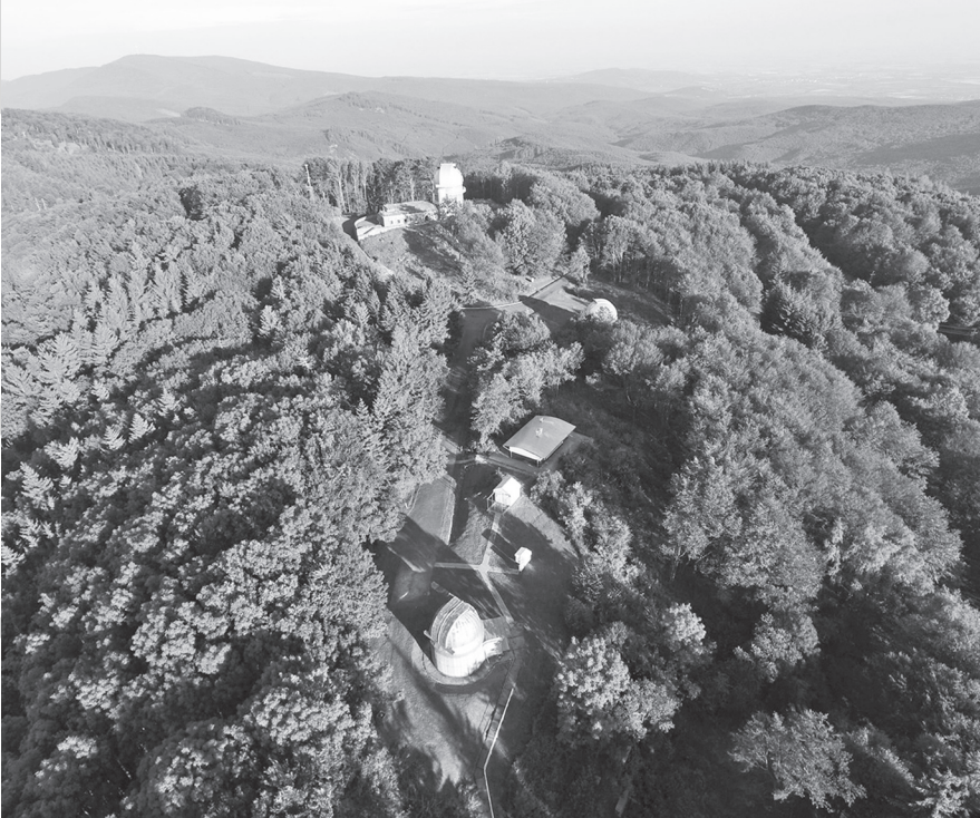
A Piszkéstetői Observatórium madártávlatból. Fentről lefelé haladva: a 1 m-es RCC-teleszkóp épülete, a Schmidt-távcső kupolája, a Nemzeti Szeizmológiai Hálózat állomása (lapos tetős épület), a 40 cm-es RC-távcső letolható tetős épülete, Légyszem-kamera, végül legalul a 80 cm-es RC-távcső kupolája
