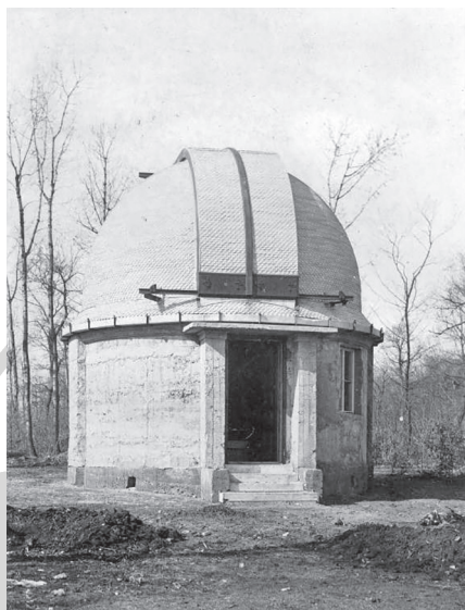
A I-es számú kupola, még építés közben. A kupola eredetileg eternitpala borítást kapott, amit később, az 1980-as években bádagra cseréltek
