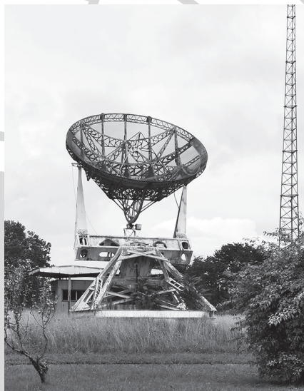
A II. világháborúból, az 1940-es évekből fennmaradt Würzburg típusú radarantennát rádiótávcsővé alakították át (Mónich László felvétele)
