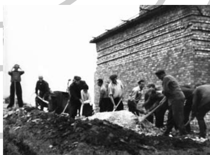
Élteképek az építés időszakából: a kupola beemlése, a kupolaszerkezet megalkotói, ózdiak az építkezésen társadalmi munkát végeznek
