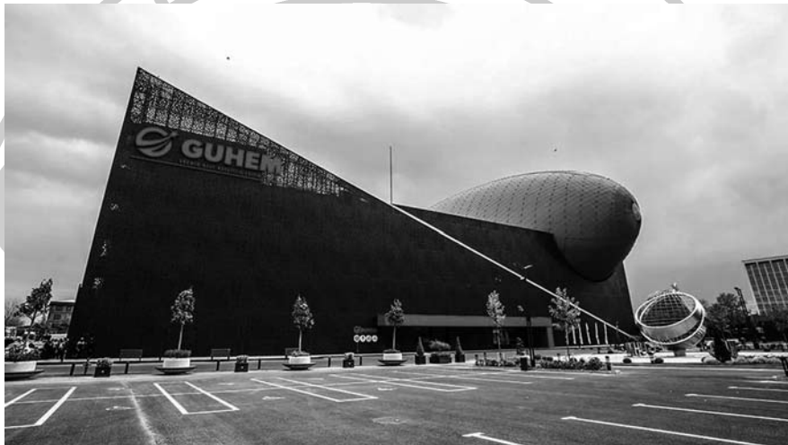
A GUHEM űrközpont hatalmas épülete (www.guhem.org.tr)
