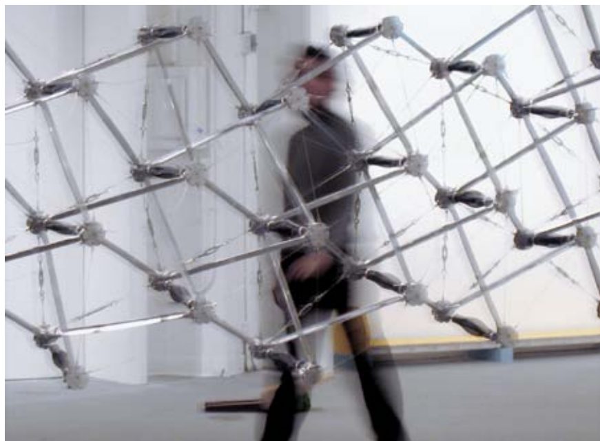
TRISTAN D'ESTRÉE STERK Tensegrity-szerkezet, prototípus, Chicago, 2004 © ORAMBRA
