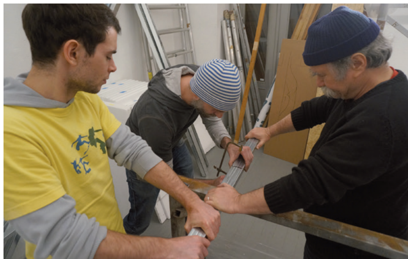
Az Eleven Mobil Pavilion építése a Labor Galériában © Fotó: Sugár János
