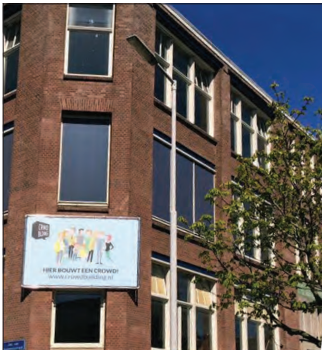
Rotterdam, Aleidisstraat 3 épülete, mai állapot ...
