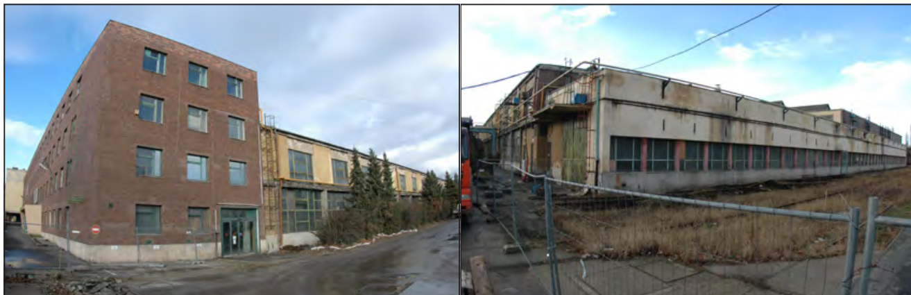
A Diesel-csarnok fejjéülete a Kőbányai út felől, és a csarnok másik vége
