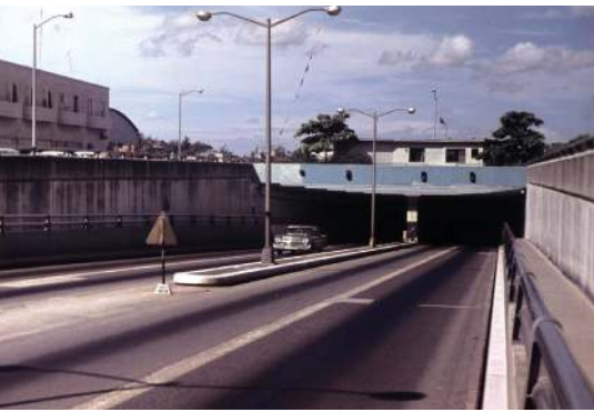
NÉGYSÁVOS ÚT AZ ALAGÚTTAL, AHOL NAPONTA KÖZLEKEDTÜNK
