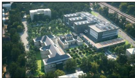
OMRRK – vezető tervező: Vasáros Zsolt DLA, Narmer Építészeti Stúdió
