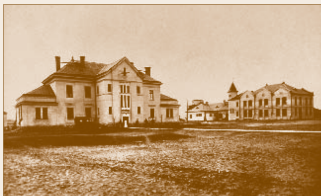
A műhelytelepi hadikórház (a későbbi iskola) épülete
