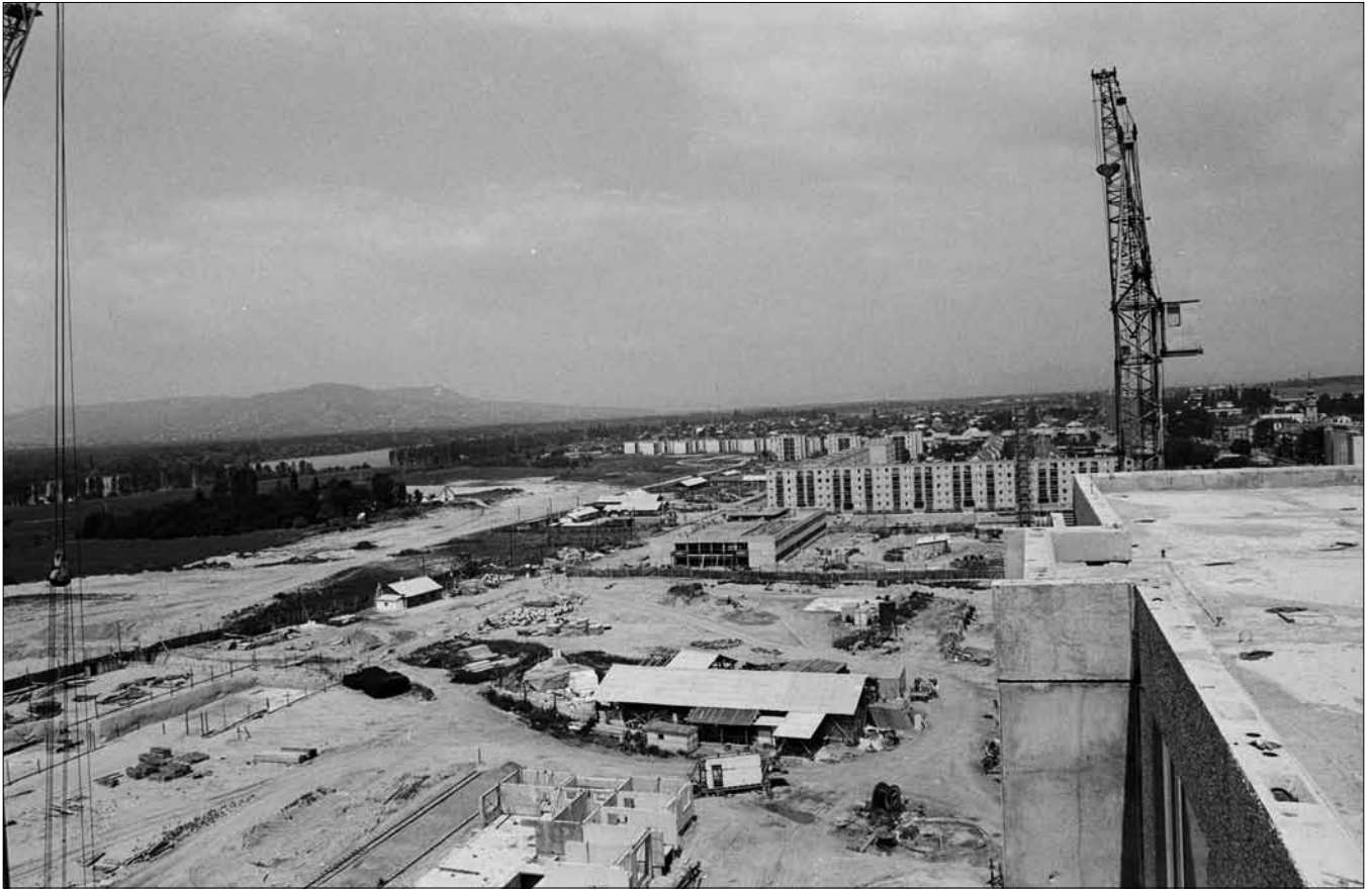
A Fő út és a Duna közötti részen megkezdődött a több ezer új lakást biztosító lakótelep építése. A kép közepén a 4. számú (mai nevén Kőrösi Csoma Sándor) általános iskola szerkezetkész épülete látható, a háttérben a már elkészült Tallér és Garas utcai négyemeletes házak tömbjei magasodnak.
