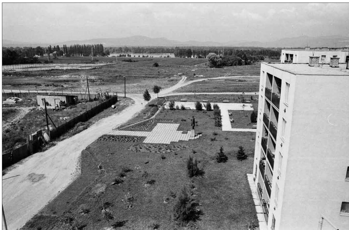
A Nap utca Duna felőli vége. A négyemeletes házak tövében álló Lenin szobor „felügyeli” a földút másik oldalán építendő tízemeletesek kivitelezéséhez megkezdett tereprendezést.
