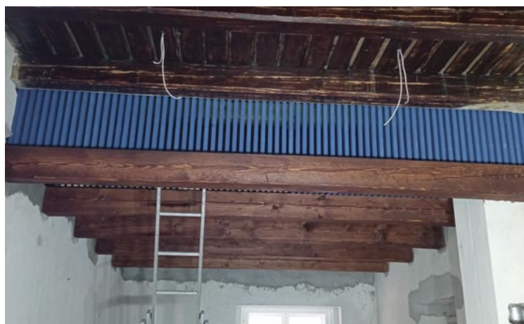
Felújítás közben: új födémgerendák és deszkázat
