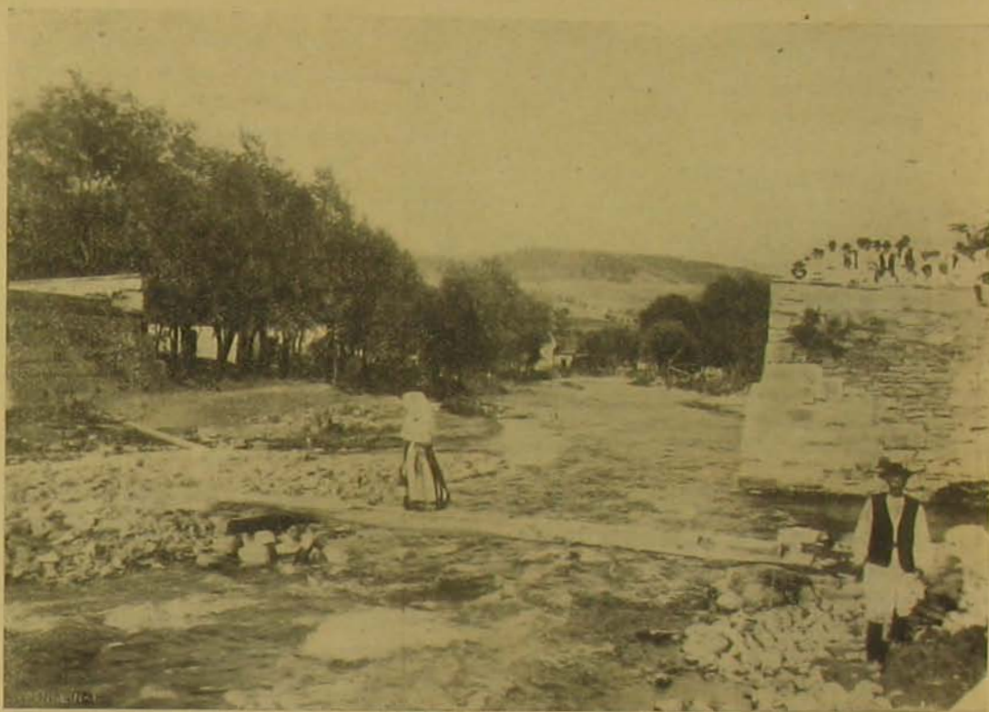
A Mohádika község két részét összekötő híd helyén csak a két hídfő látható. A hidat, melyet a víz pozdorjává zúzott s a melyet meg sem találtak, palló helyettesíti.
