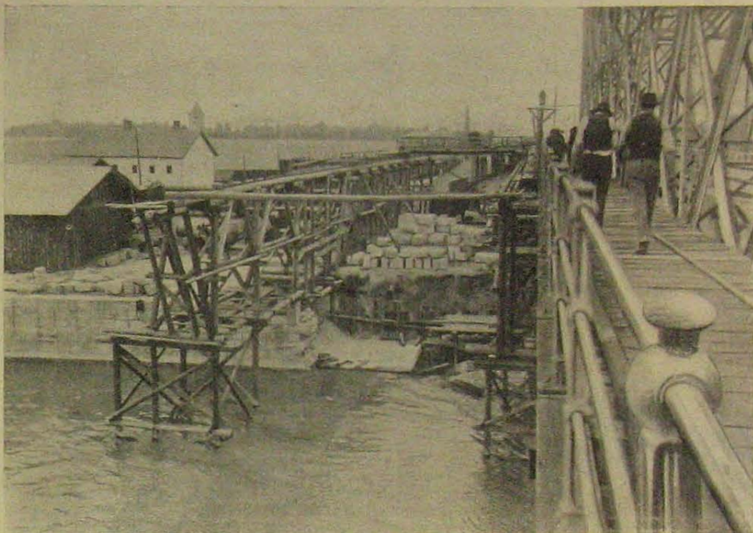
A pesti híd építése a Dunáról nézve.
