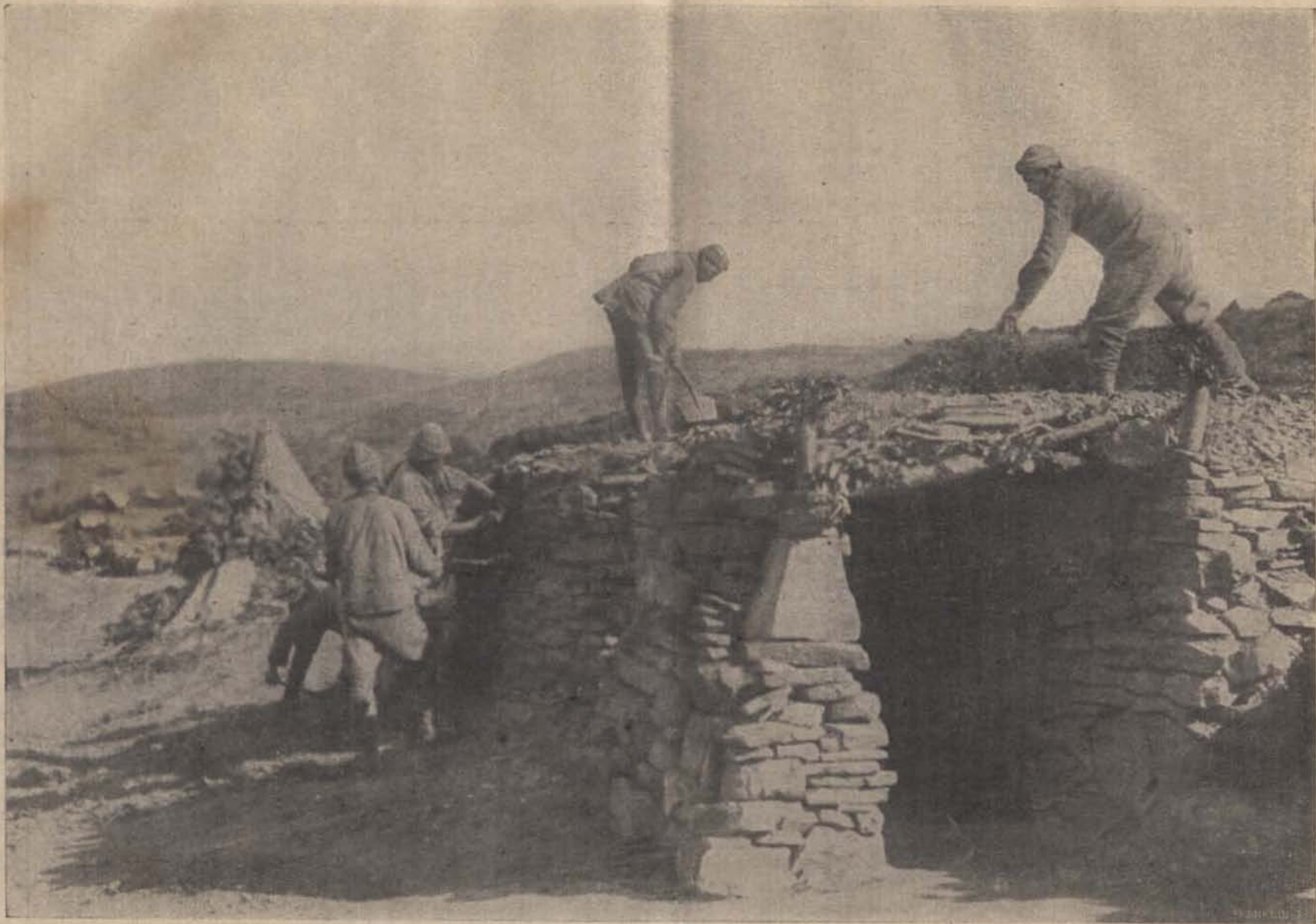
A gallipolii harcokból. — Épülő fedezékek.
