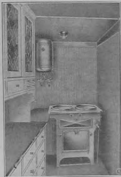
A Zeppelin III. léghajó elektromos konyhája. Az áramot egy hat lóerős dinamó szolgáltatja, amelyet szélturbína hajt.
