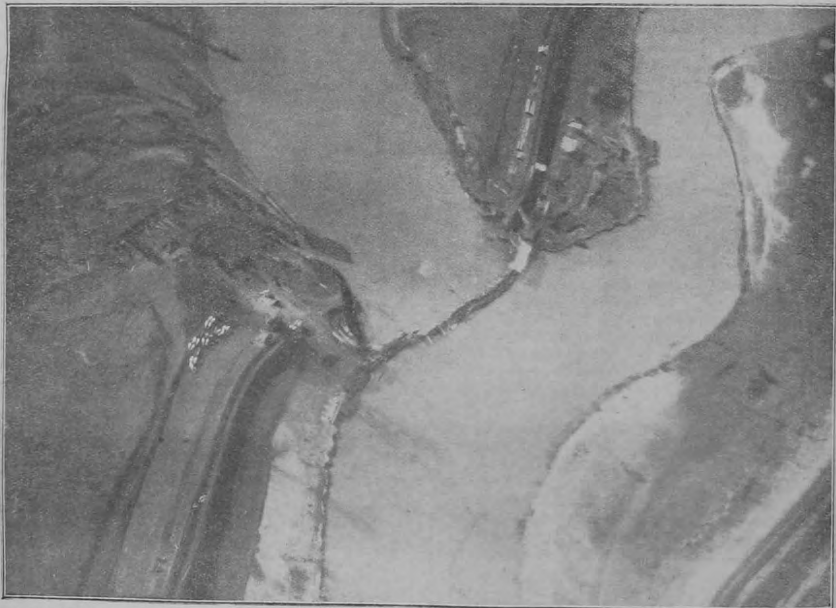
Repülőfelvétel az alföldi nagy árvízről. A komádi gátszakadás. (A képen látni lehet, hogy az árvíz a vasúti töltést hol szakította át. A kép baloldalán menekülők ökrösszekerei láthatók.)
