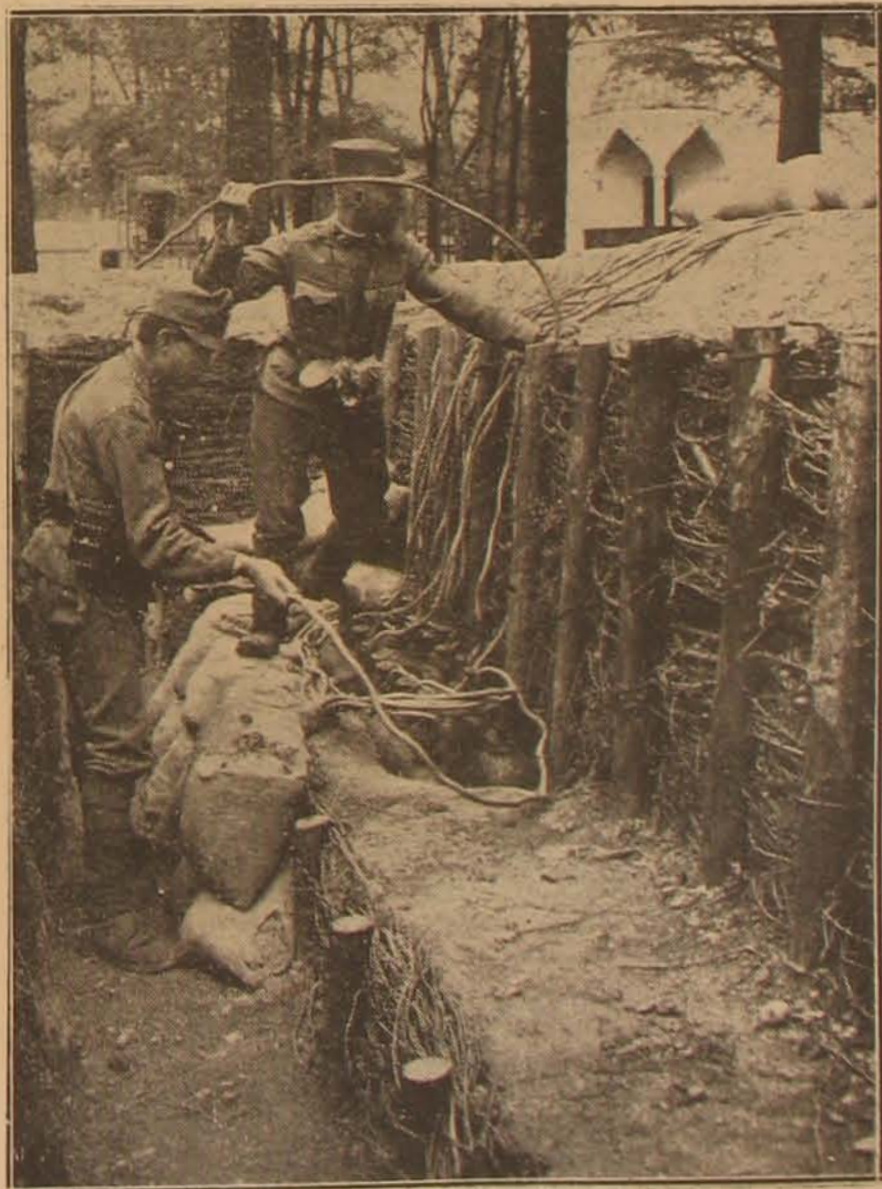
5. ábra A gázpalackok ólomcsöveinek átvezetése a mellvéden
