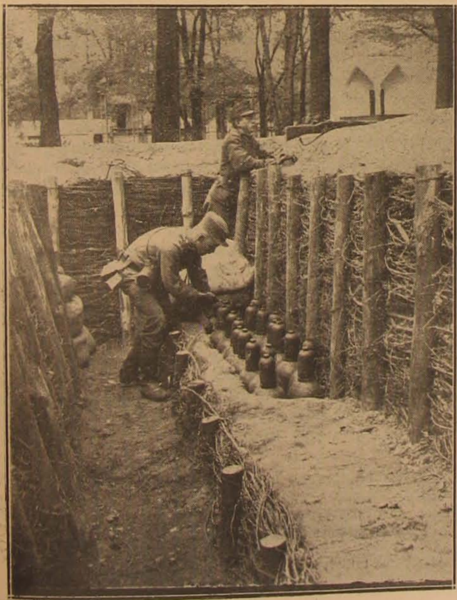
3. ábra: Gázpalackok beépítése.
