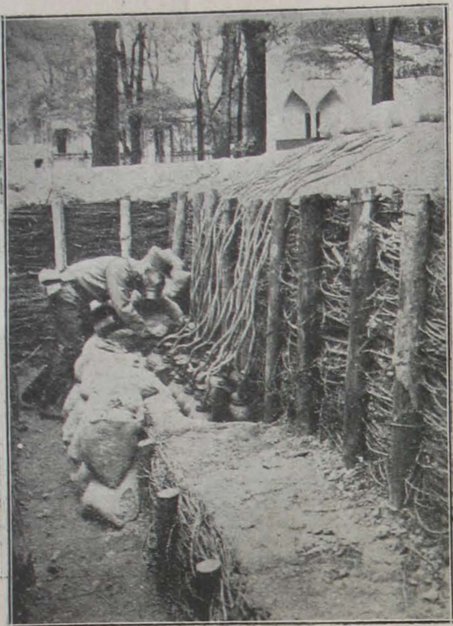
6. ábra: A gázipalackok kinyitása. (Ma már villamos árammal, központilag nyitják.)
