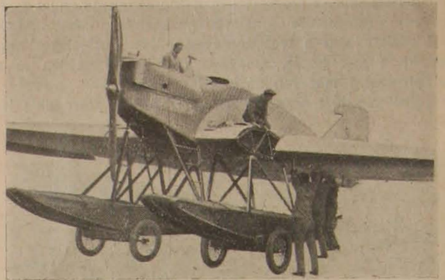
7. ábra: Egysíkú vaslagszárnyú vizi-szárzsföldi fémgép (amphibia) kélszárnyú húzó légcsavarral.
