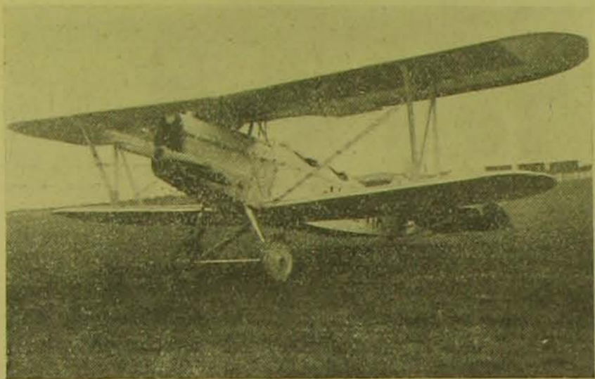
2. ábra: Kétsíkú, vastagszárnyú, kerekes (szárazföldi) futószerkezettű repülőgép kétszárnyú húzó légcsonnyal.
