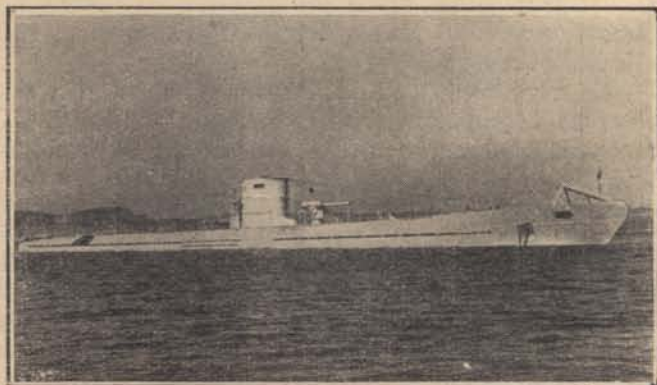
U 25 német búvárnaszád (1936-ban épült; víz felett 712 t. vízkiszorítású; víz felett 18, víz alatt 8 csomó sebességű; 1 db. 10,5 cm. ágyúja, 1 géppuskája, 6 db. 53,3 cm. torpedóvetőcsőve van; 71 m. hosszú, 6,2 m. széles, legénysége: 40 fő).
