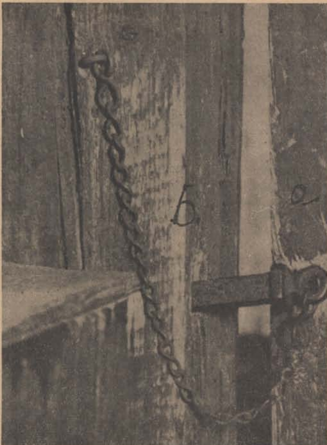
Az elhasználódás következtében a raktárajtó (a) és a raktárfalak (b) között támadt rés az elhatároló ütközővel.
